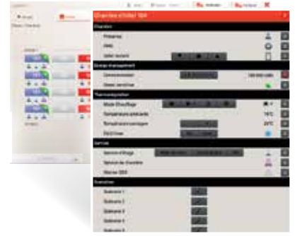
OTEL ODASI GÖRÜNTÜLEME VE KONTROL. GENEL GÖRÜNÜM VE DETAYLI GÖRÜNÜM EKRANI
