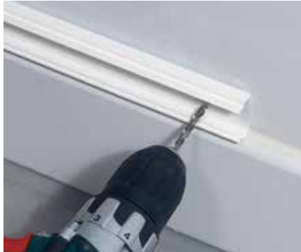
2 Duvarın yapısına gre, vida veya ivi kullanarak kablo kanalını duvara sabitleyin.
