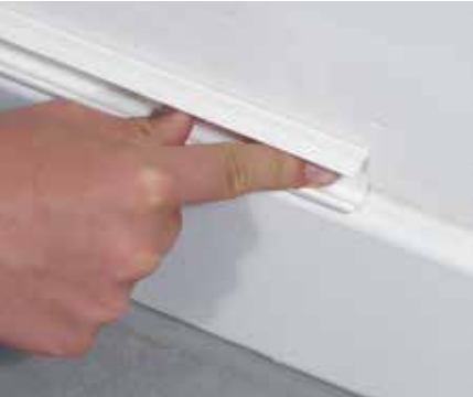
1 Kablo kanalını duvar zerinde istediėiniz konuma getirin.
