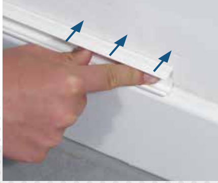
2 Kablo kanalını istediėiniz konuma getirin ve duvara doėru kuvvetlice bastırın. Kalın yapışkan bant duvardaki przleri doldurarak gl yapışma saėlar.
