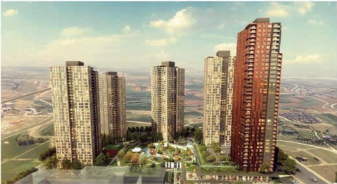
750 daireden oluşan Atabilge İncek Konutları'nda Legrand marka şalt kullanıldı.
