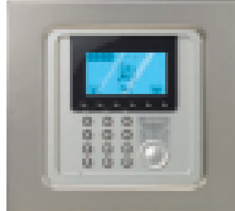
Merkezi hırsız alarm ünitesi
